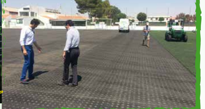
Sustitución césped campo de fútbol
