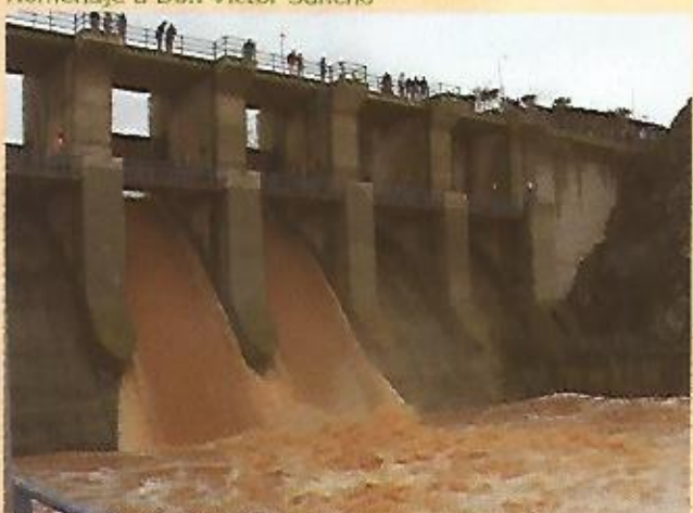
Inundación de la planta potabilizadora
