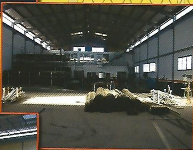
NAVE DE TRABAJO
