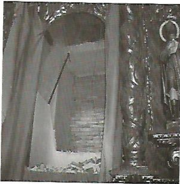
Hueco de la ventana-camarín
